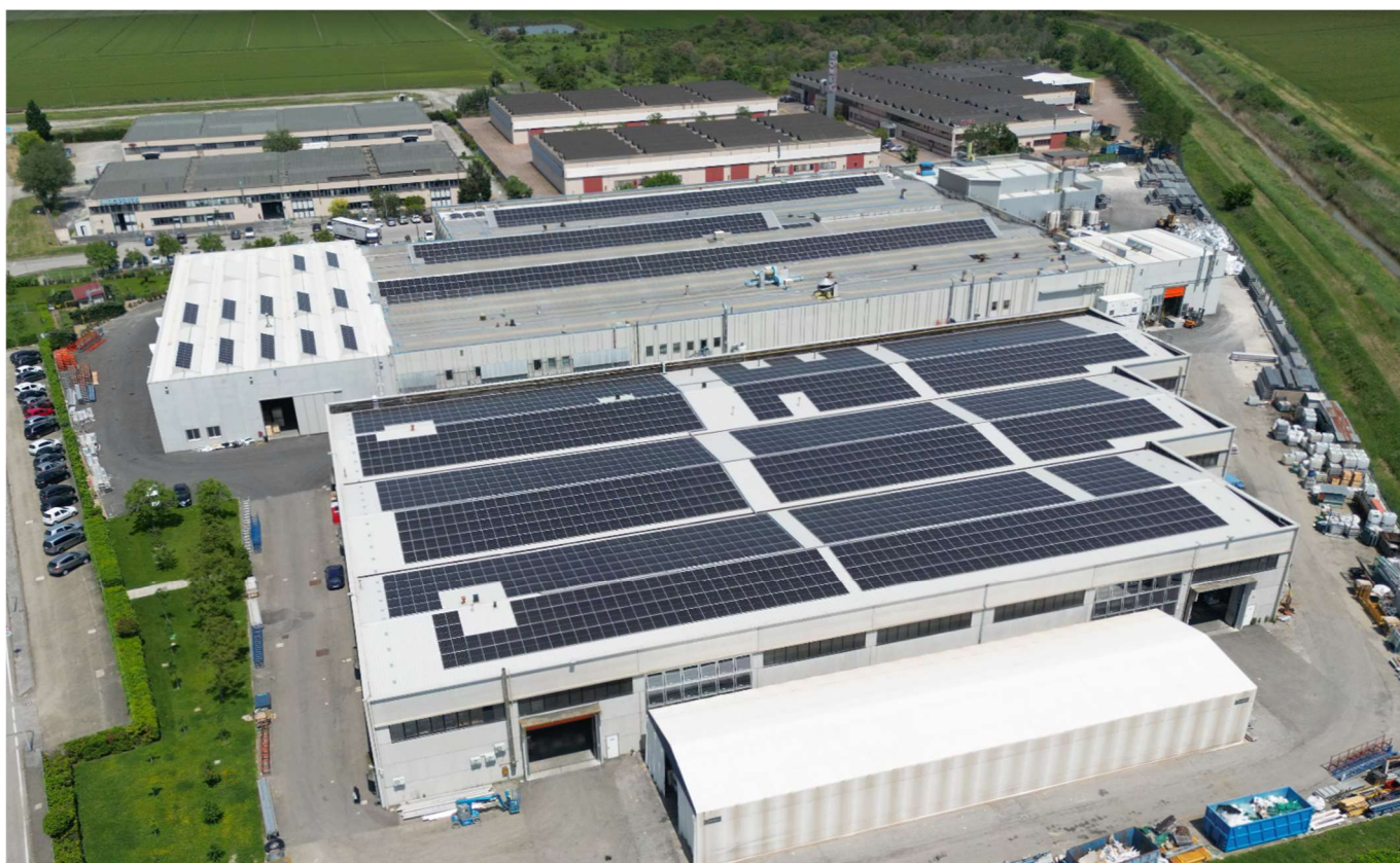
FIGURA 3: VISTA DALL'ALTO DELL'IMPIANTO
